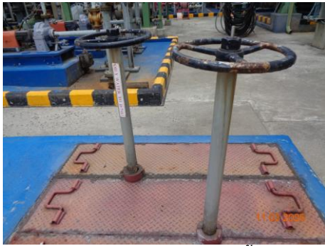
ภาพที่ 2.2-15 ประตู/วาล์วระบายน้ำที่เชื่อมกับ บ่อพักน้ำฝน
