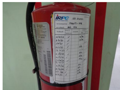
ภาพที่ 2.2-22 การตรวจสอบอุปกรณ์ป้องกันและ ระงับอัคคีภัย
